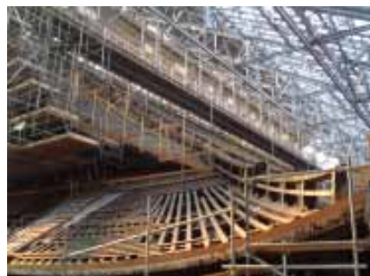
妻側から見た現在の状況
