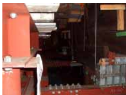
小屋組内部の補強状況
