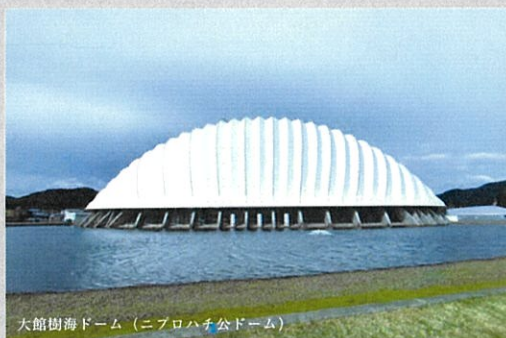
大館樹海ドーム (ニプロハチ公ドーム)
