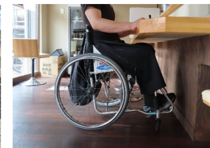
ローカウンターを設置
