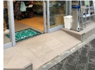
スロープの設置
