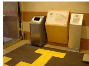
視覚障害者誘導用ブロック、点字による案内板の設置
