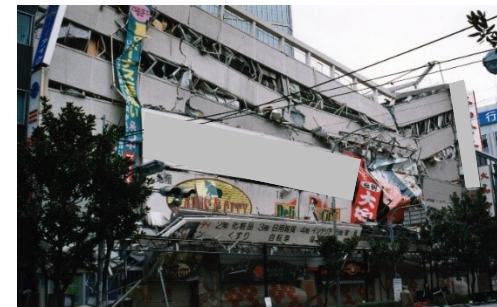
地震により崩壊した大規模店舗 (写真提供:神戸市、国土交通省にて一部加工)
