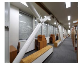
補強材(筋かい)の設置
