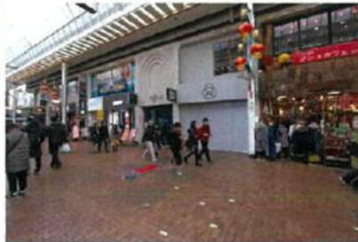
キタムラ K2 前レンガ テスト施工箇所
