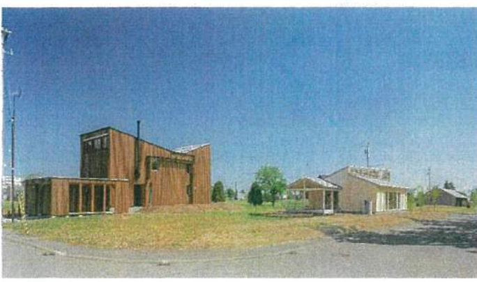
完成したモデル住宅
