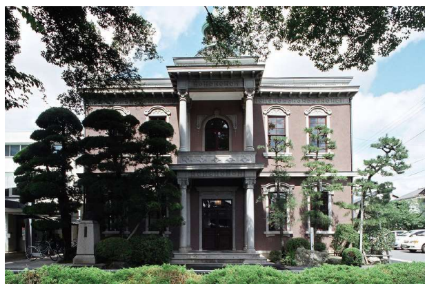
▲中島病院旧本館 (城西浪漫館)
