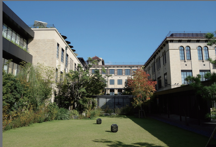
旧清水小学校(現・ホテル青龍 1933年竣工／京都市営繕課設計)
