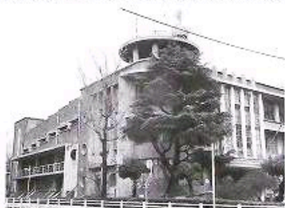
改修工事のため閉鎖された 御影公会堂＝神戸市東灘区 御影石町4
