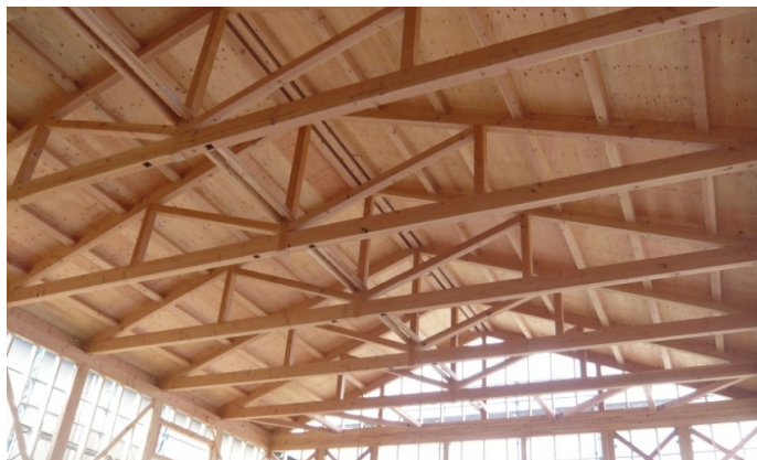
流通製材と住宅用プレカットによる12mスパン山形トラス
