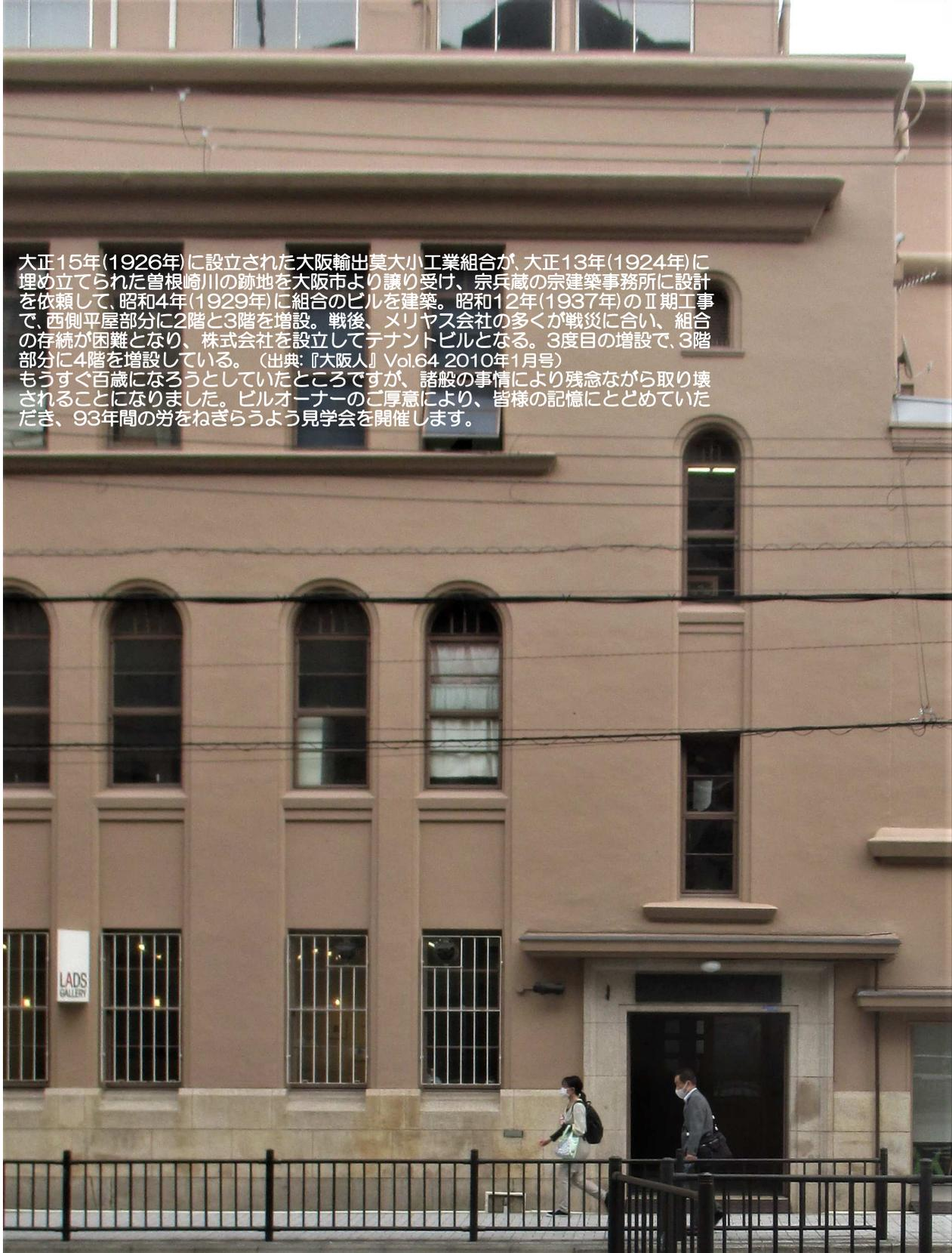
大正15年(1926年)に設立された大阪輸出莫大小工業組合が、大正13年(1924年)に埋め立てられた曾根崎川の跡地を大阪市より譲り受け、宗兵蔵の宗建築事務所設計を依頼して、昭和4年(1929年)に組合のビルを建築。昭和12年(1937年)のⅡ期工事で、西側平屋部分に2階と3階を増設。戦後、メリヤス会社の多くが戦災に合い、組合の存続が困難となり、株式会社を設立してテナントビルとなる。3度目の増設で、3階部分に4階を増設している。(出典:『大阪人』Vol.64 2010年1月号)
