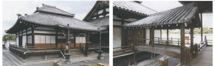
本堂 修理前外観
